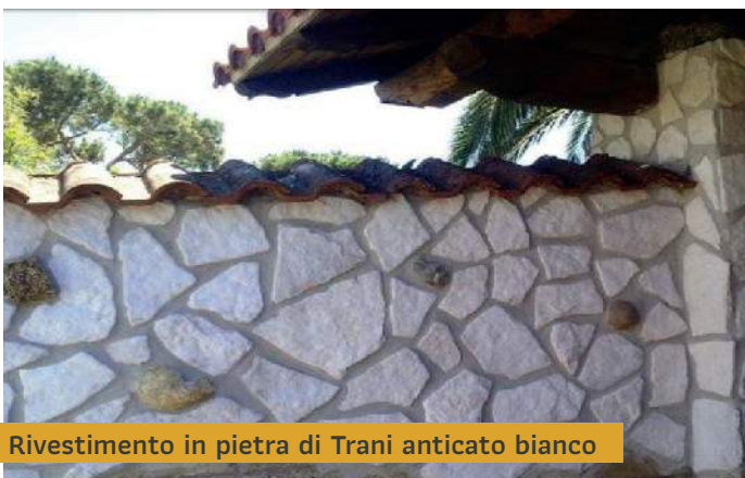
Rivestimento in pietra di Trani grezza squadrata
