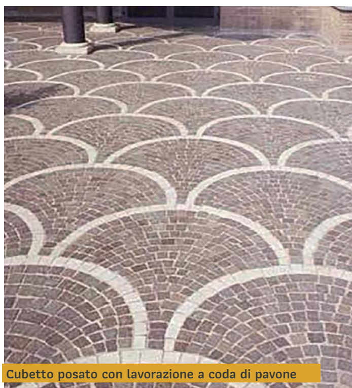
Cubetto di porfido posato con lavorazione ad arco contrastante
