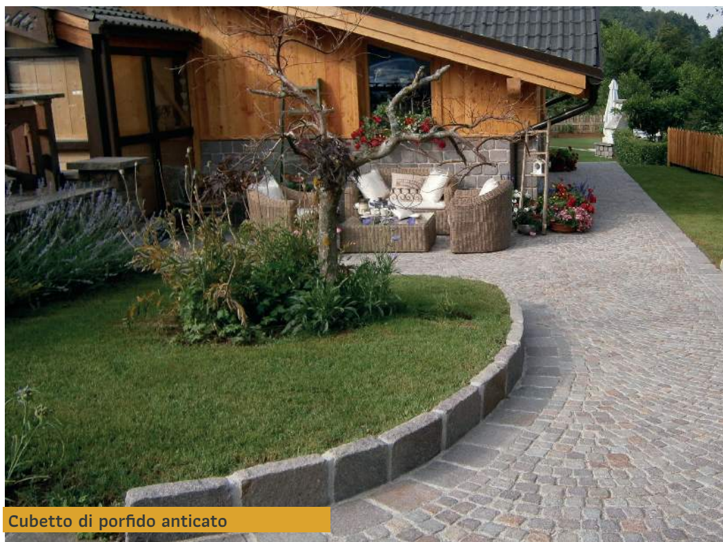
Cubetto di porfido posato con lavorazione ad arco contrastante
